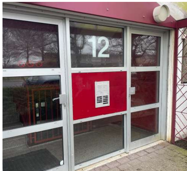
Nye opgangsdøre og partier
